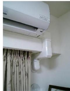
■マンションは、スリーブ穴が決まっているために配管が露出となります。化粧カバーを使用することで配管の保護にもなり、スッキリとした仕上がりになります。※室外機側の配管も化粧カバーで保護します。
